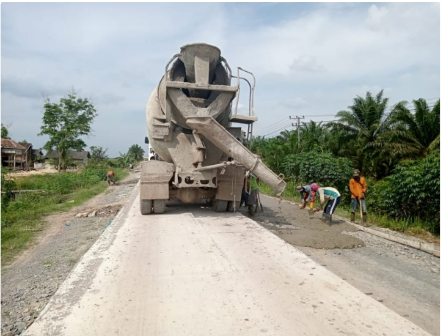
Bangun Jalan Rigid Beton KTM Wonosari
