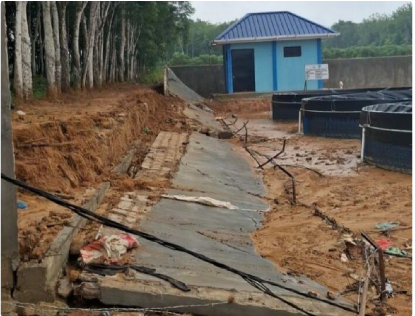
Pagar pembatas Balai Benih Ikan (BBI) Air Tawar di Mesuji -Bukoposo Roboh
