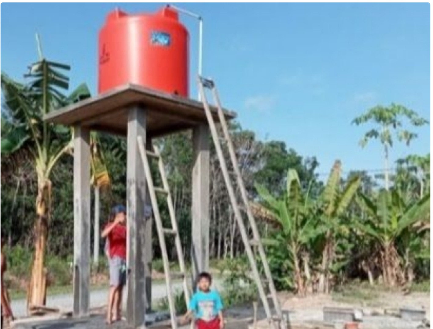
Pembangunan sumur bor di Desa Fajar Baru
