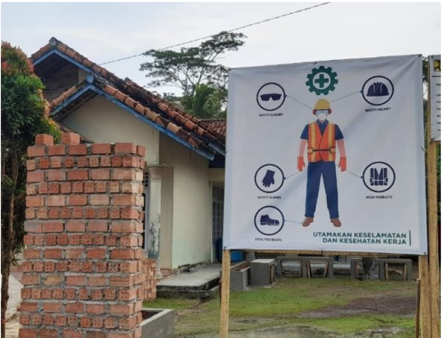
Proyek Infrastruktur Hunian Hijau di Mesuji
